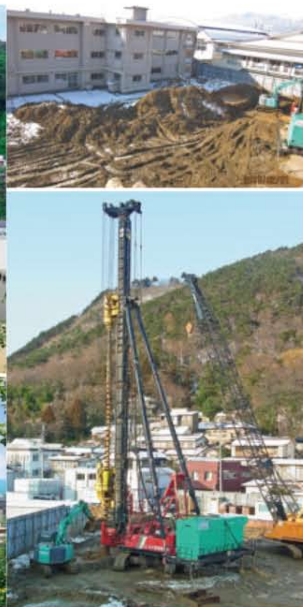
現在の様子 基礎工事
